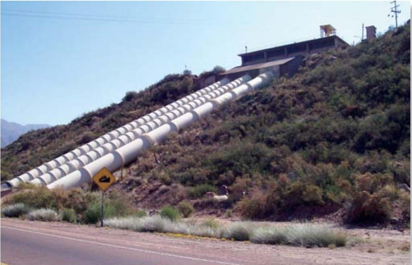
Vista de los tres conductos y de la obra de embocadura de la cámara de carga.
