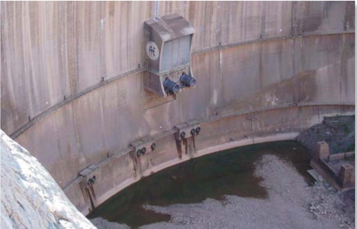
Vista en detalle de las válvulas de chorro hueco de las derivaciones de riego y ocho de los diez descargadores para sólidos en suspensión.
