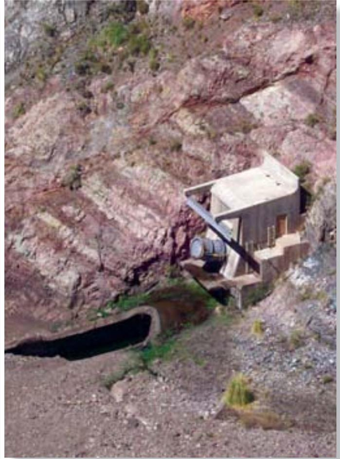
En la imagen de la izquierda se aprecia el descargador de fondo respecto a la presa. A la derecha (acercamiento), se muestra en detalle la válvula de chorro hueco a la salida del descargador de fondo.
