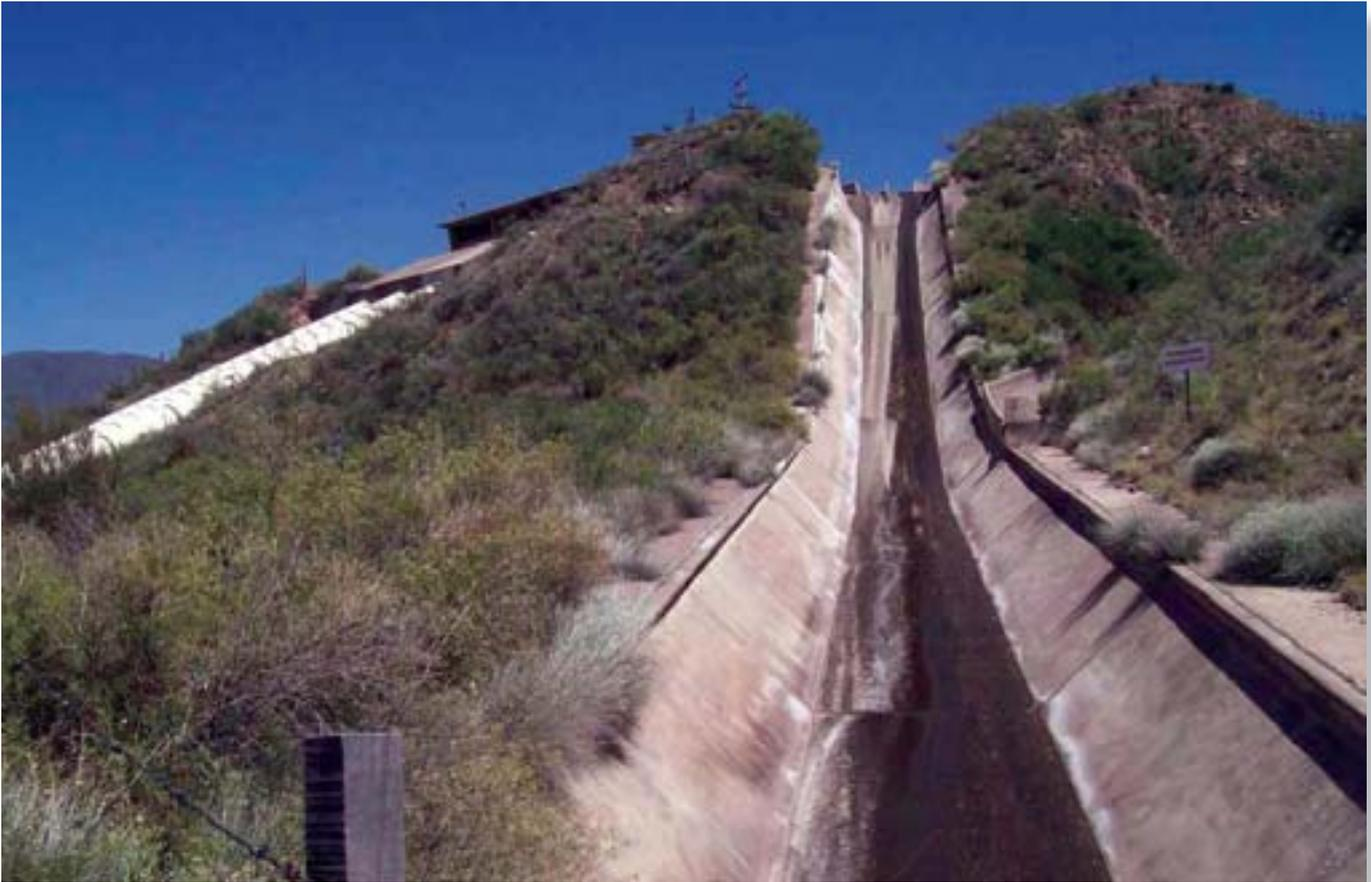
Vista de la rápida del canal de fuga. A la izquierda se aprecian las conducciones a la central.
