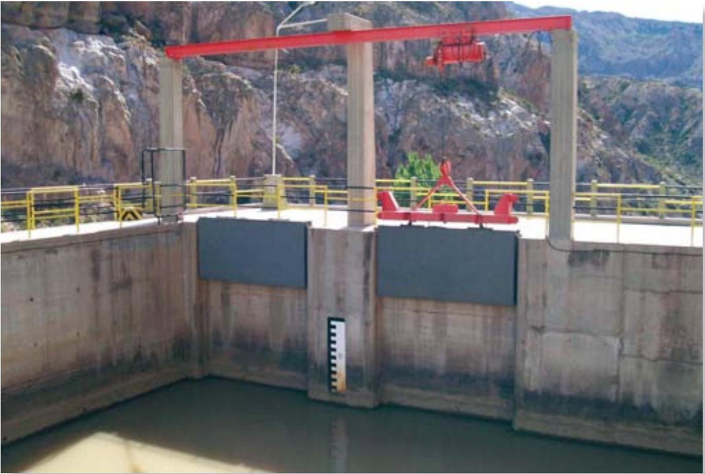
Vista de la toma de los descargadores de fondo. Obsérvese las compuertas de cierre.
