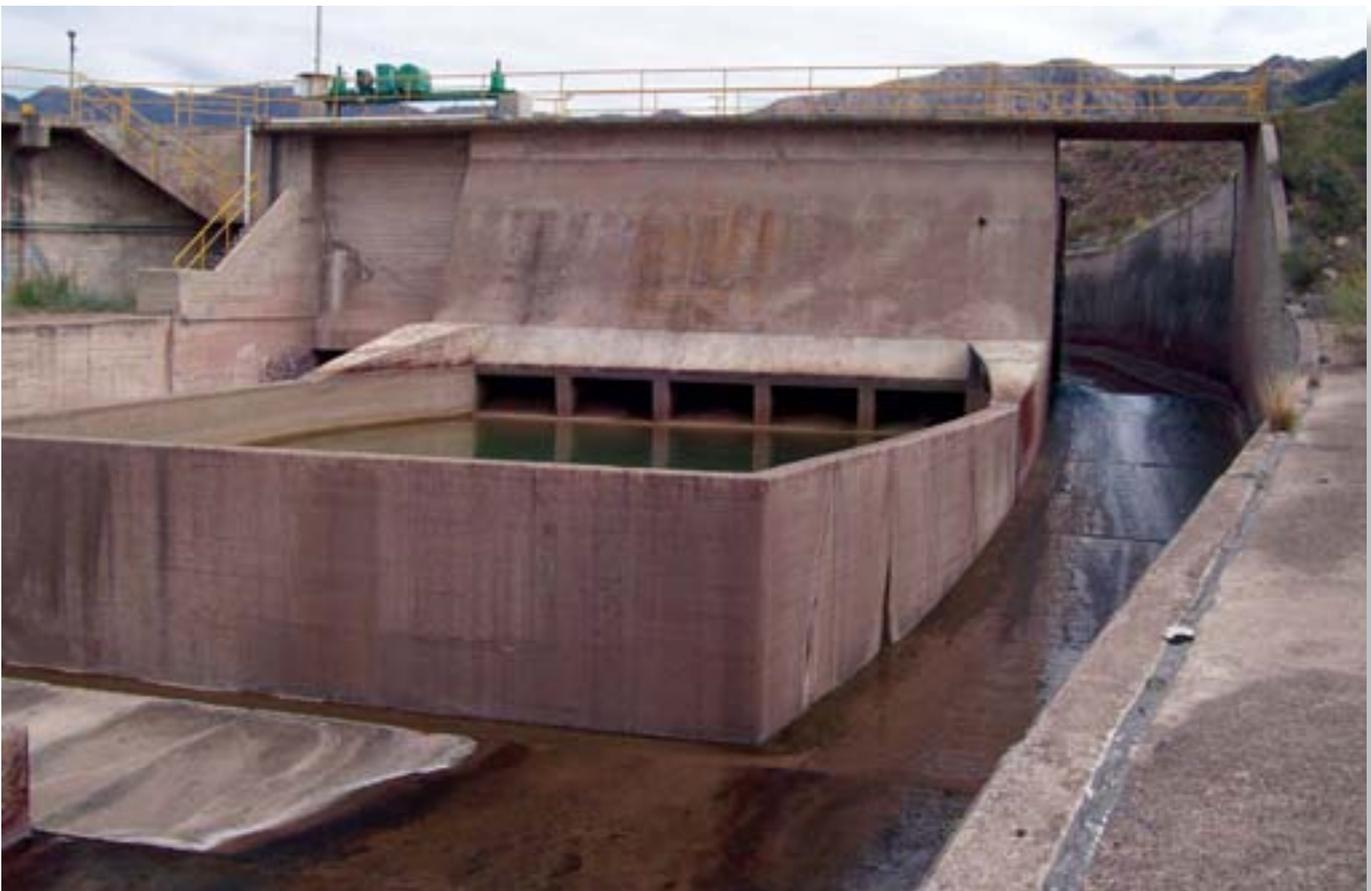
Vista desde aguas abajo del sifón de descarga con su cuenco dissipador de energía y del canal del vertedero lateral.
