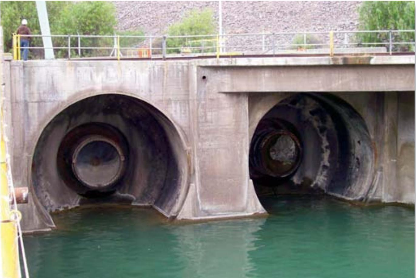
Vista de las válvulas de chorro hueco de la derivación de riego. Nótese el blindaje en acero a la salida de ambas válvulas.
