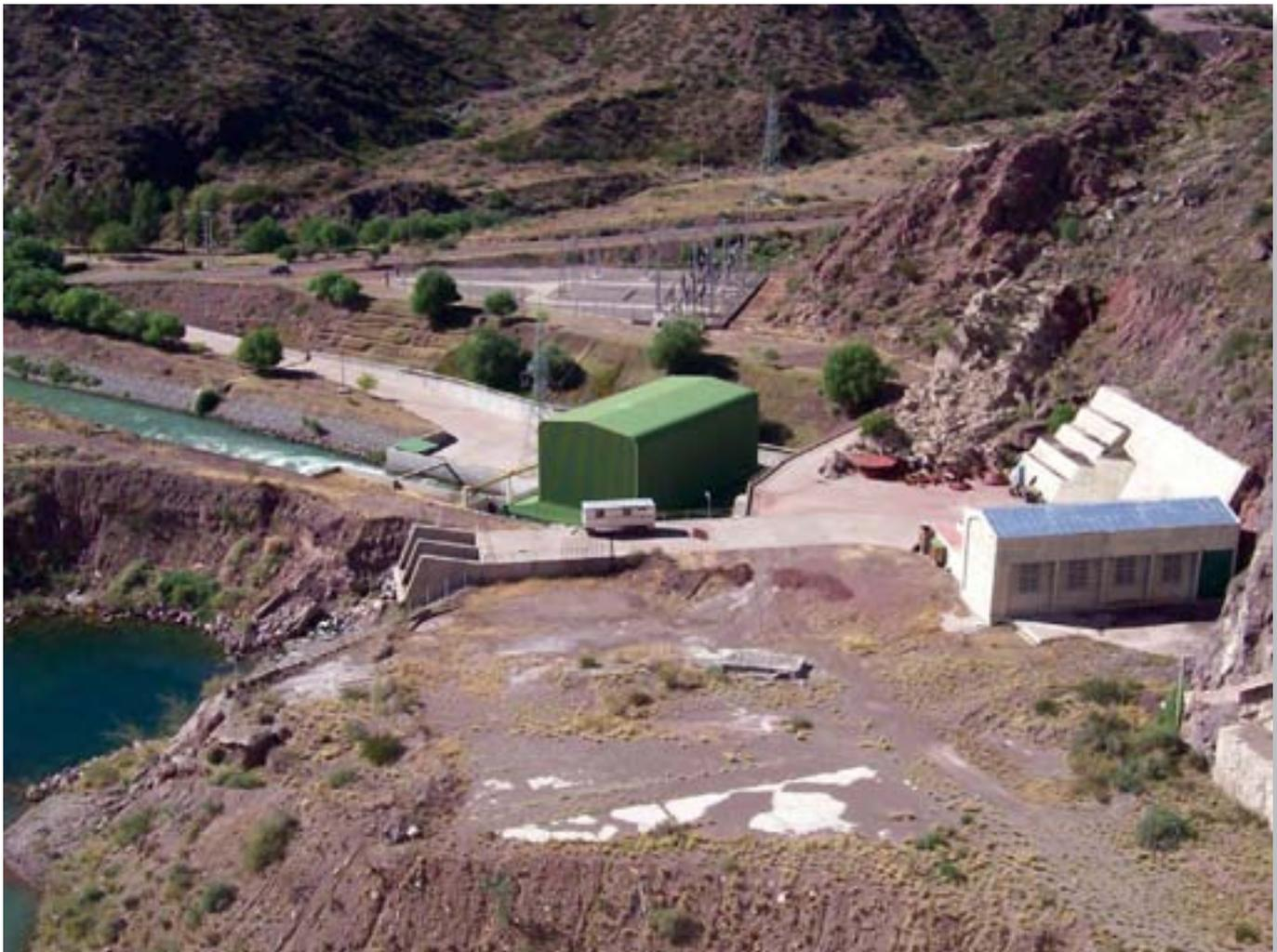
Vista general de las derivaciones de riego y de la central. A la derecha se observa la casa de válvulas, a la izquierda la salida con salto de esquí de la descarga a riego, al centro el edificio de la central con su canal de restitución al río.
