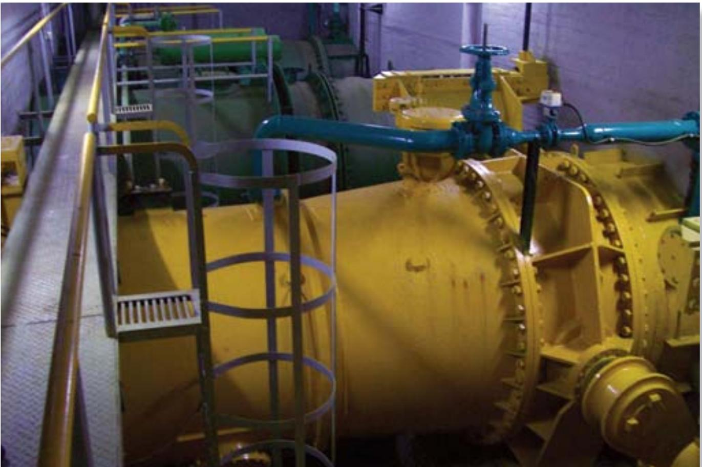
Vista de la casa de válvulas, al fondo se aprecian las válvulas de la conducción a la central y en primer plano, una de las destinadas a riego.
