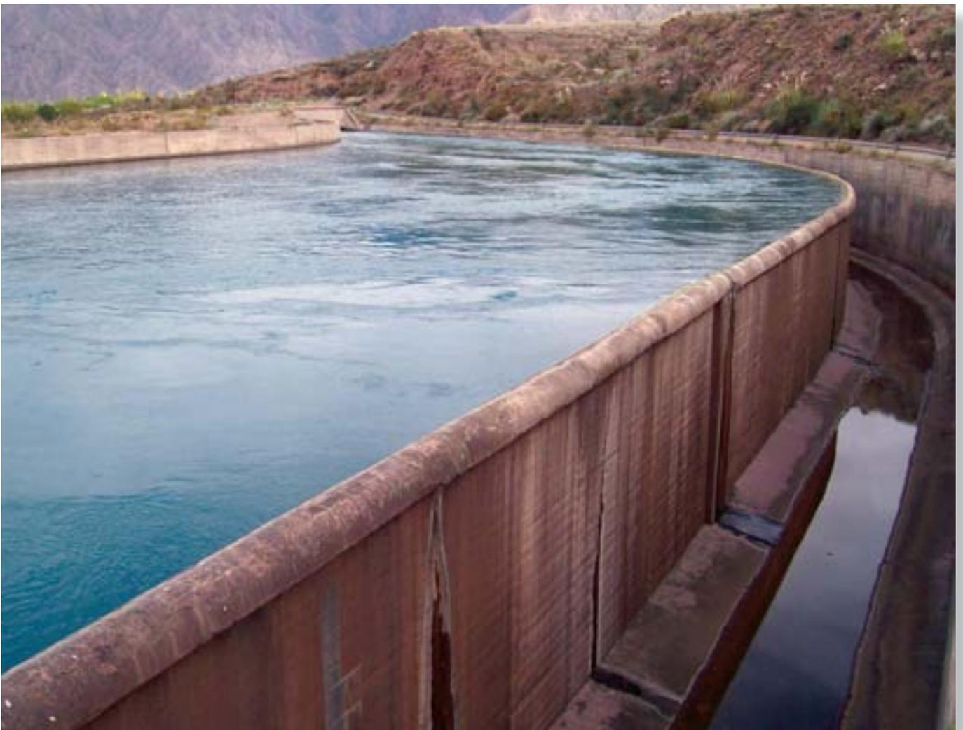
Vista de detalle del vertedero lateral que regula el nivel de la cámara de carga.
