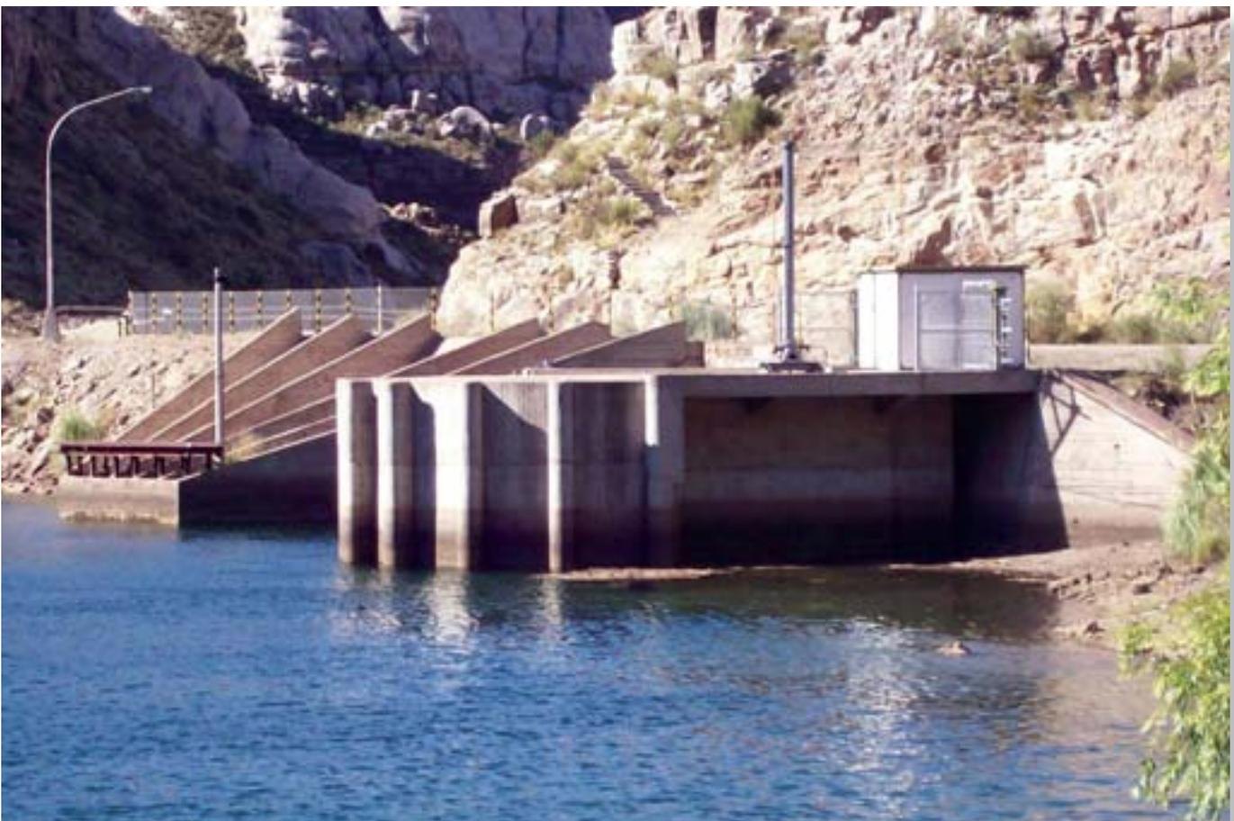
Vista de la obra de toma de la conducción a la central. Obsévese las guías de las rejas y el mecanismo hidráulico de accionamiento de apertura, junto a la casilla de comando.
