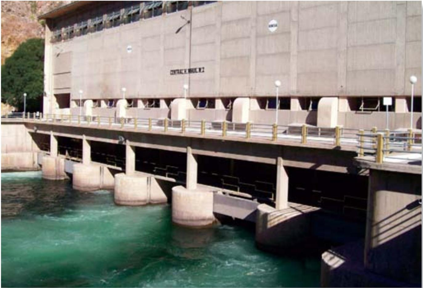
Vista de la central Nihuil II. Se aprecian las compuertas de cierre del canal de restitución de la misma.
