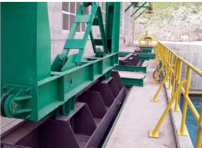
Vista de las compuertas de cierre de la dársena de restitución al río de la central Cacheuta.
