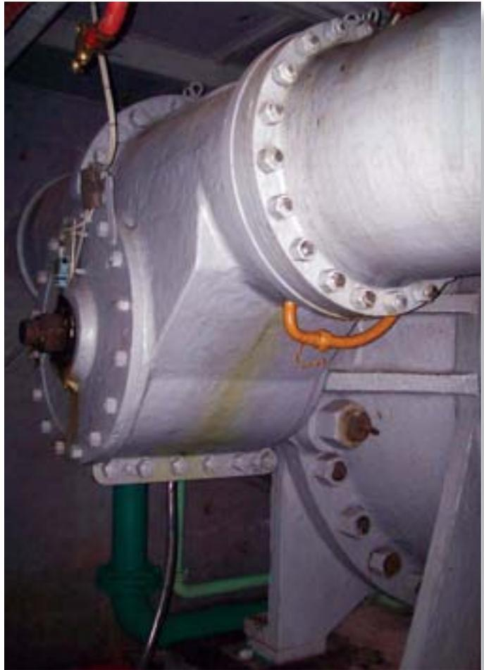
Vista de la válvula esférica y su accionamiento, previo al ingreso del agua a la cámara espiral de las turbinas.
