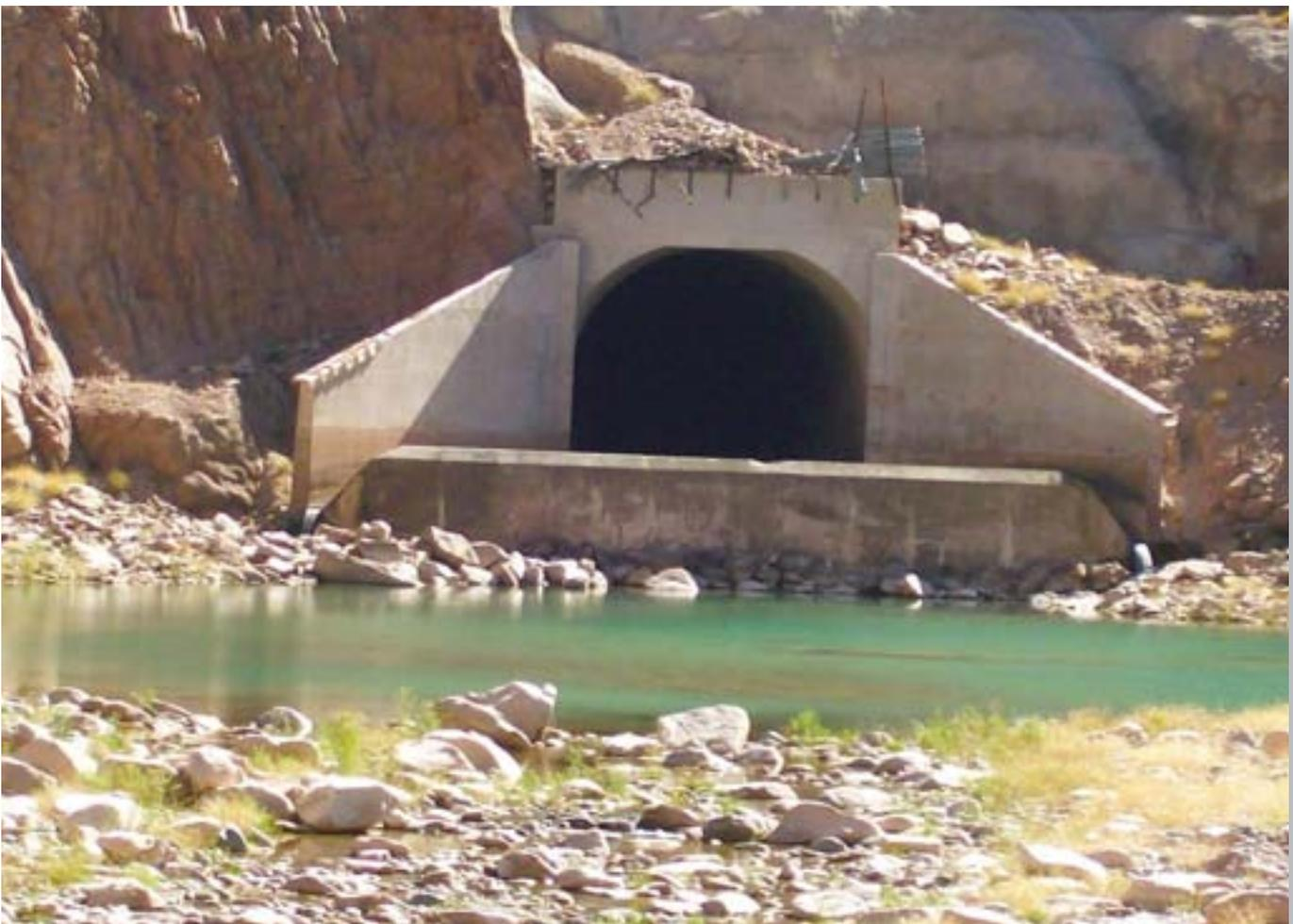
Vista de la salida del descargador de fondo y del salto de esquí para disipar la energía del flujo de agua.
