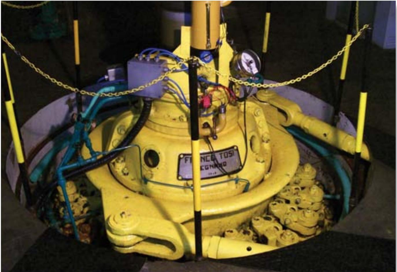
Vista del anillo del distribuidor de una de las turbinas, se puede apreciar los brazos accionadores.
