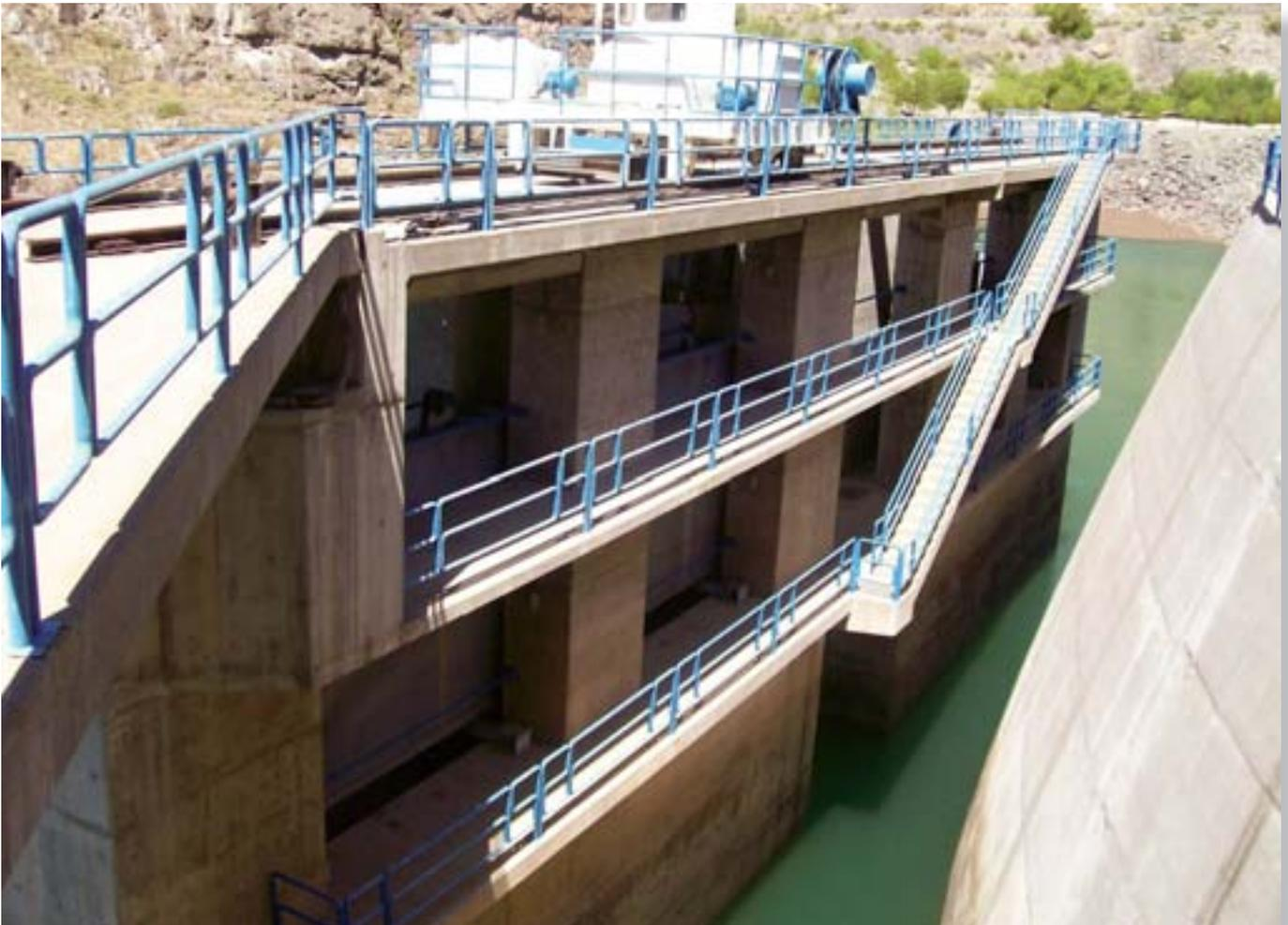
Vista de detalle de la estructura y las compuertas de cierre de los conductos de restitución de la central al río.
