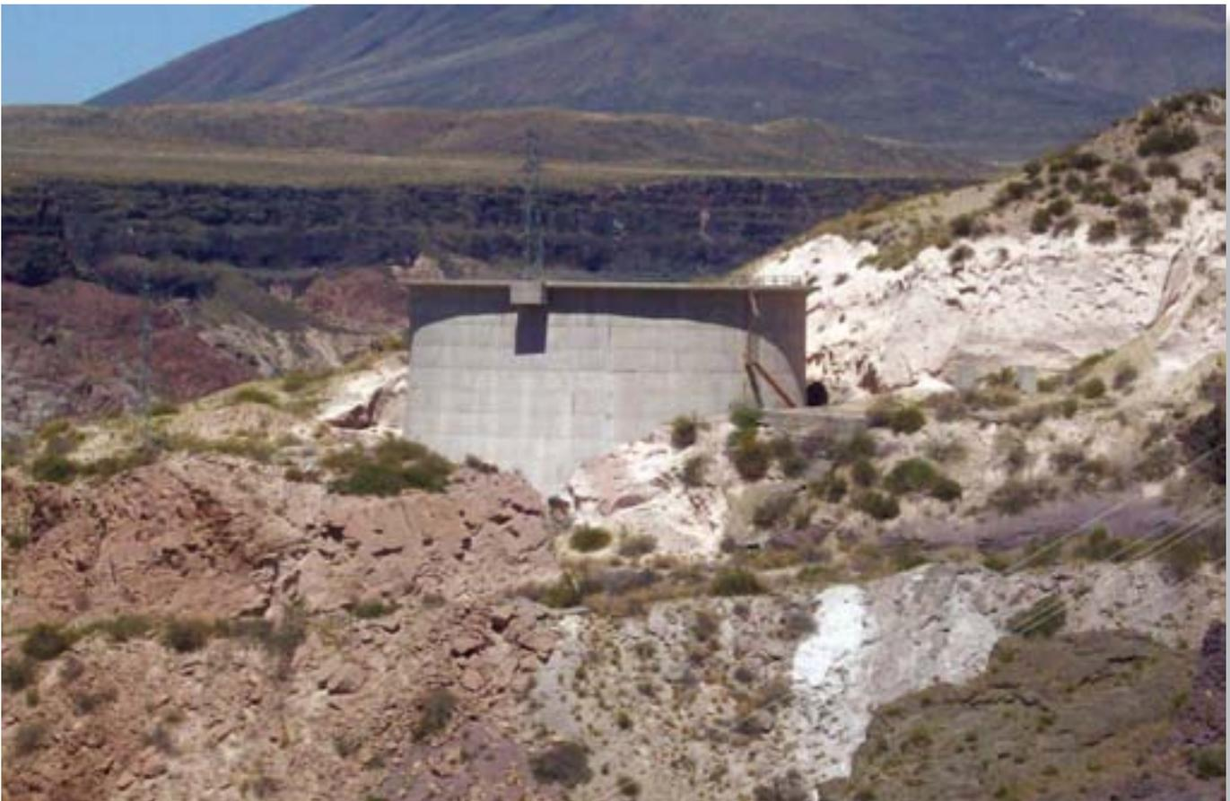
Vista de la chimenea de equilibrio de la tubería de conducción a la central hidroeléctrica.
