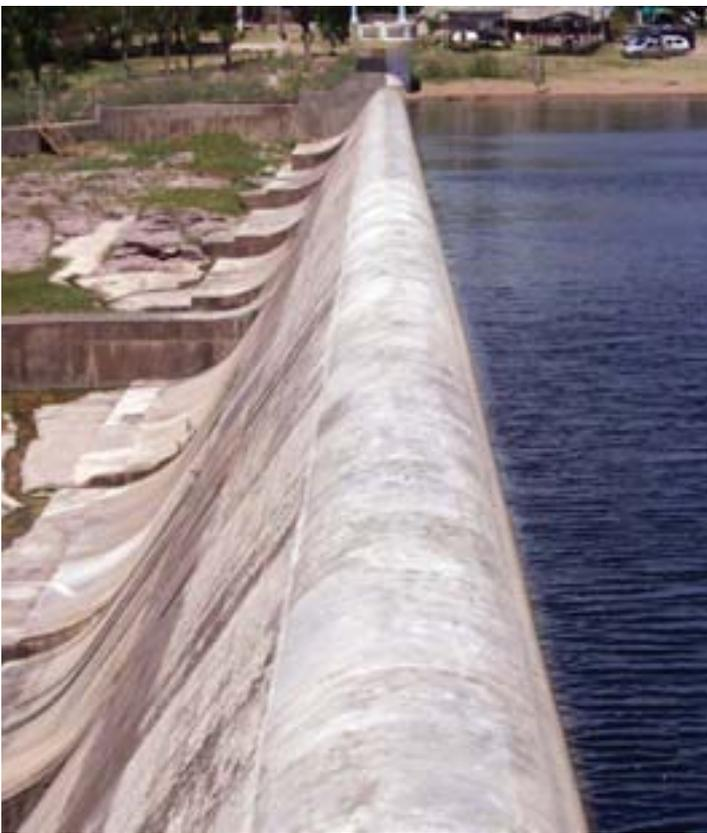
Vista de detalle del labio del vertedero. Véase los muros y la salida al cauce natural del río.
