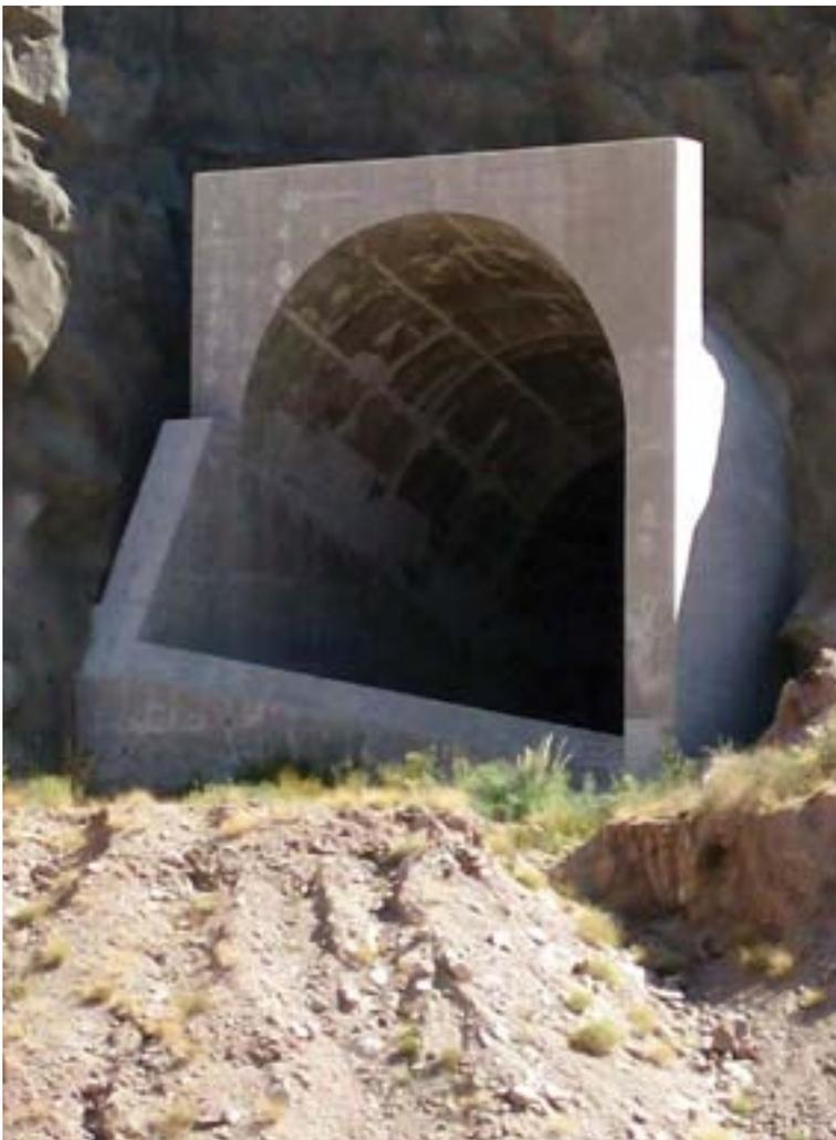
Vista de la salida de la conducción del vertedero, donde se aprecia el salto de esquí.
