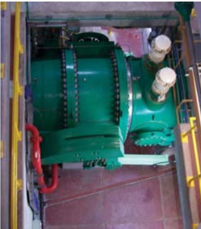
Vista de la válvula mariposa de cierre previa a la cámara espiral de las turbinas de la central Cacheuta.
