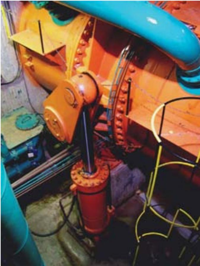
Vista de la válvula mariposa y de su sistema de accionamiento, previo al ingreso del agua en la cámara espiral.
