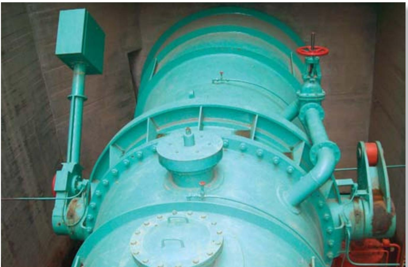
Vista de la válvula mariposa de la derivación de riego.
