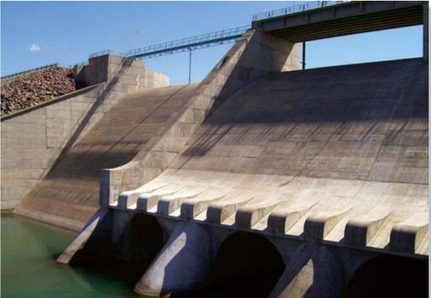
Vista del aliviadero completo. Se pueden apreciar las salidas y el sistema de disipación sobre el canal de restitución de la central y de la derivación para riego.
