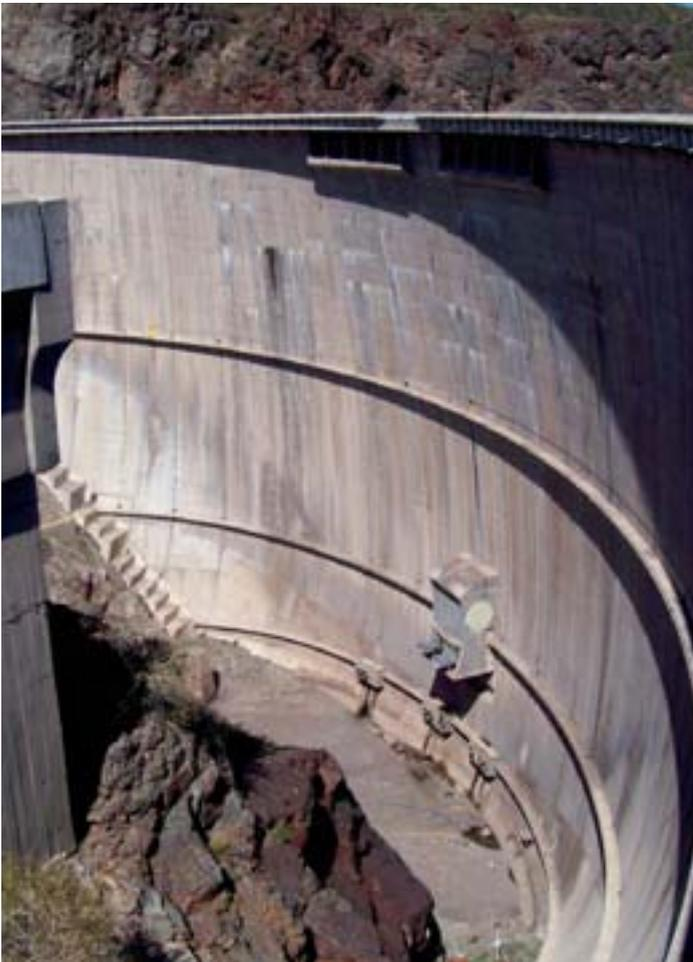
Vista del paramento aguas abajo, donde se aprecia claramente la curvatura de la presa, la casilla de las descargas de riego (centro) y ocho de las diez descargas de materiales sólidos en suspensión.
