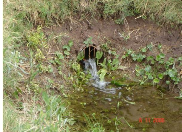
Foto 16: tubería de drenaje perforada enterrada que está eliminado el exceso de agua del suelo
