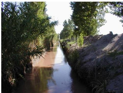
Foto 8: canal de distribución de agua sin revestir
