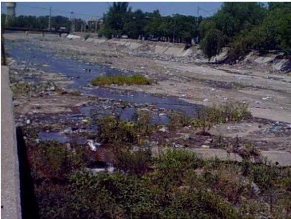
Foto 17: colector aluvional contaminado
