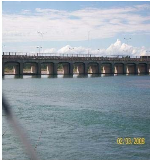
Dique Cipolletti (Fuente: Panoramio)
