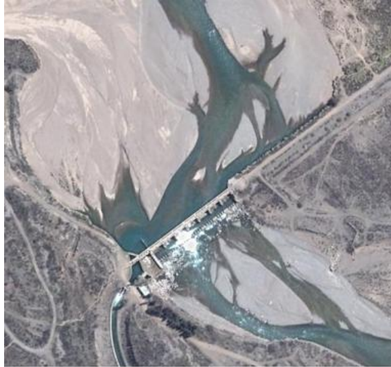
Dique Compuertas (Google Earth) Altura del ojo 5.000 m
