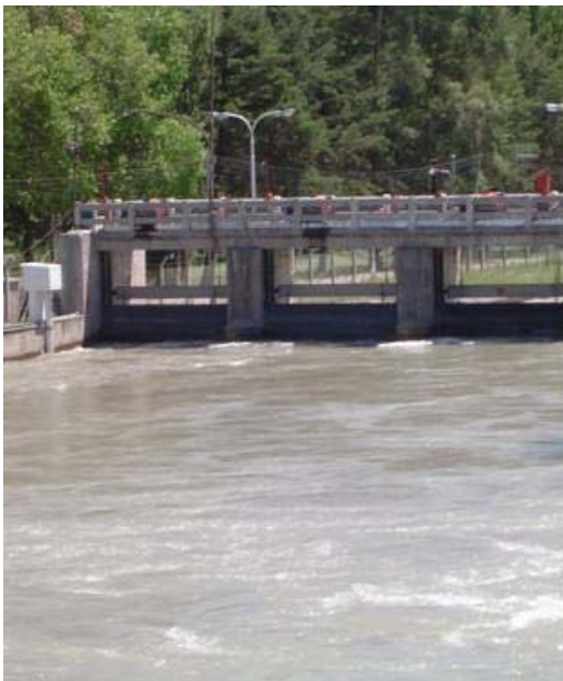
Compuertas del Dique Cipolletti (Fuente: Panoramio)
