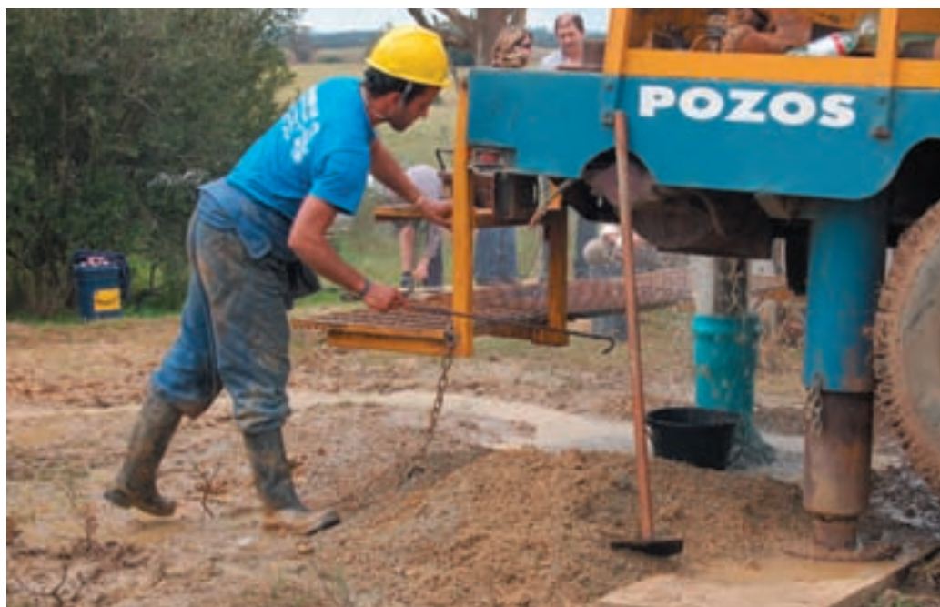
Fig.22. Perforador durante la construcción de un pozo.
