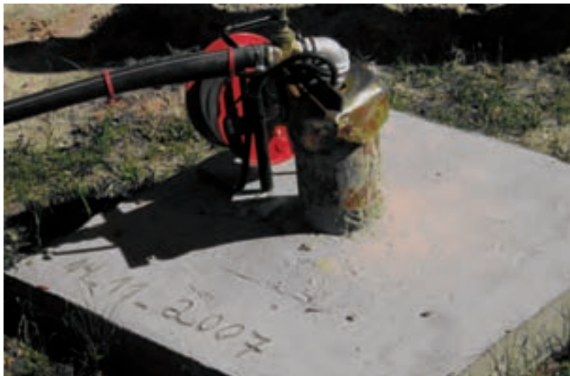
Fig. 28. Losa sanitaria. Terminación en superficie
