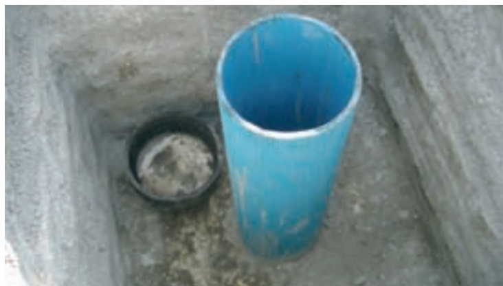
Fig. 23. Tubería sanitaria no apropiada para revestimiento de pozo
