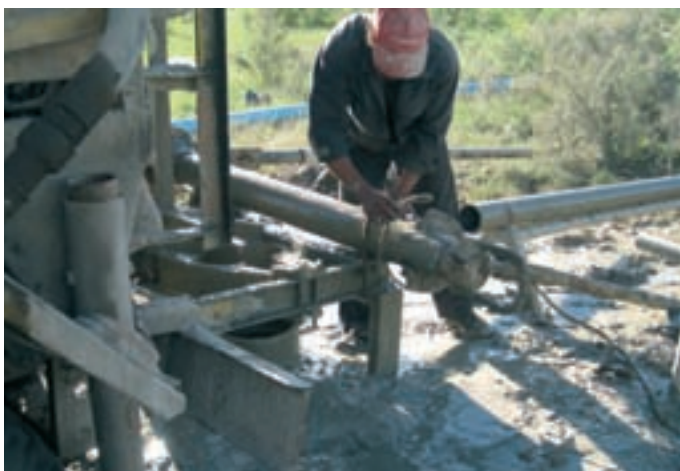
Fig. 17. Máquina perforadora. Método de rotopercusión
