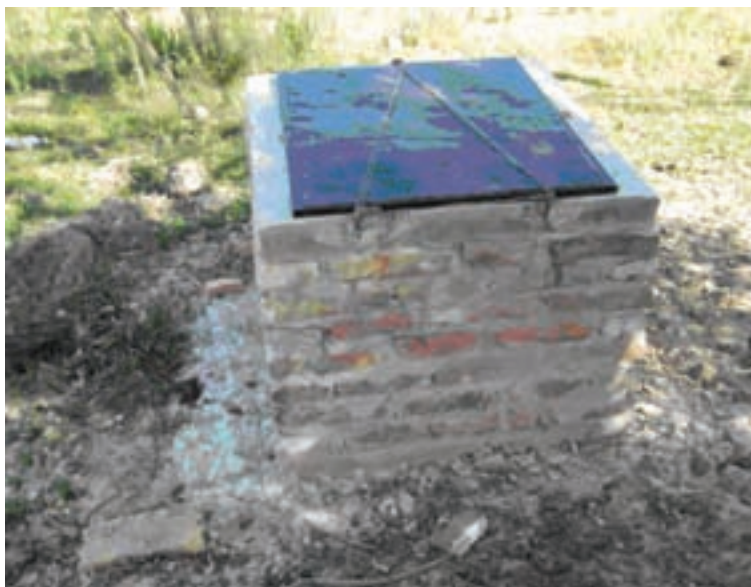
Fig. 29. Casilla de protección de pozo
