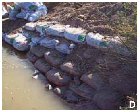
Figura 24.- Colocación de bolsas con tierra y rizomas: A) y B) colocación de bolsas en seco; C) y D) colocación de bolsas con presencia de agua en la cárcava.
