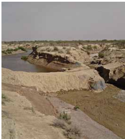
Figura 29.- Daño en un extremo del terraplén de La Pasarela ante la ausencia de membrana geotextil.
