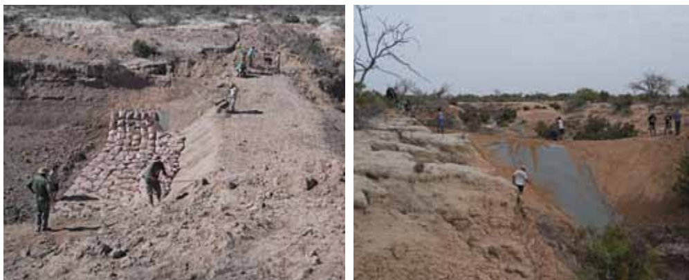
Figura 25.- Revestimiento final del terraplén.
