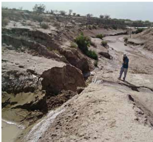
Figura 29.- Daño en un extremo del terraplén de La Pasarela ante la ausencia de membrana geotextil.
