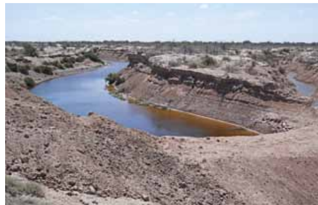
Figura 27.- Obra La Pasarela después de la primera lluvia de la temporada. Los vecinos aseguran que esta agua duraría todo el verano...
