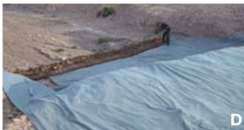
Figura 23.- Proceso de colocación y fijación de la membrana geotextil: A) preparación de la membrana geotextil, B) cubrimiento del terraplén, C) fijación con estacas de hierro y D) anclaje mediante zanja.
