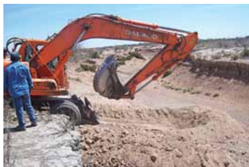
Figuras 21.- Trabajo de las máquinas para consolidar el terraplén.
